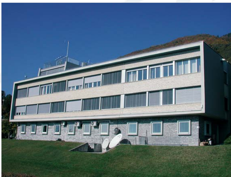
◀ Das Gebäude in Locarno-Monti.
