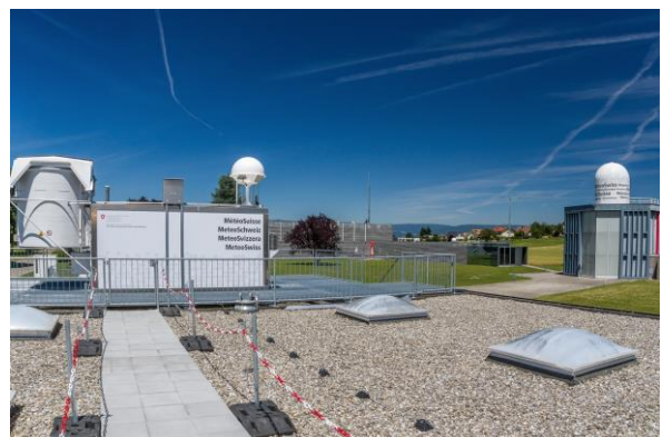
Links die Anlage zur automatischen Auflassung der Ballonsonden und rechts die Halle, in der die Ballons für die spezifischen Radiosondierungen gefüllt werden.
